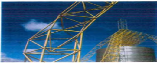
A 棟頂樓桁架照片(1)
