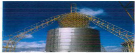
B 棟頂樓桁架照片(2)
