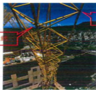
桁架接頭照片(14)
