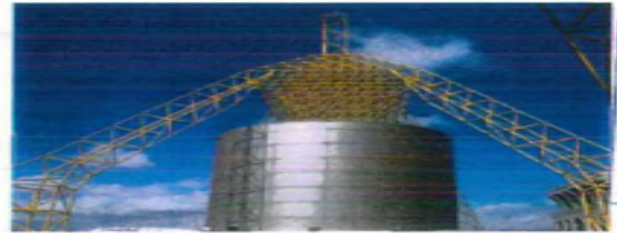
B 棟頂樓桁架照片(2)
