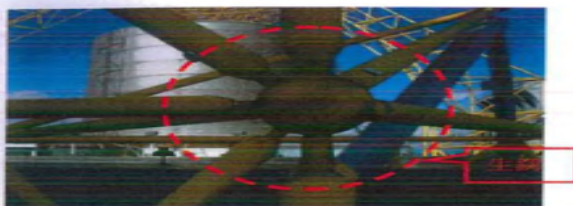
桁架接頭照片(9)
