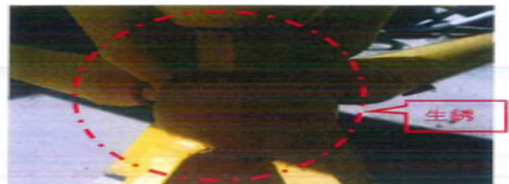
桁架接頭照片(8)
