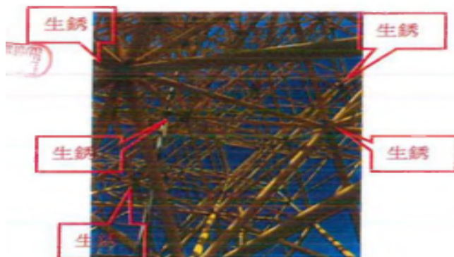
桁架接頭照片(15)
