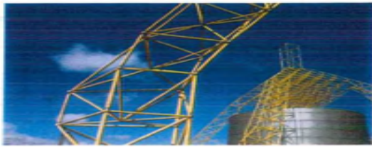
A 棟頂樓桁架照片(1)
