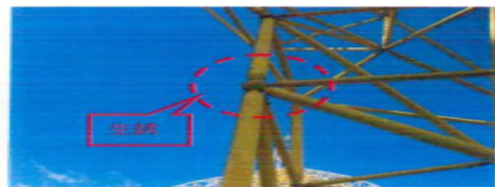
桁架接頭照片(10)
