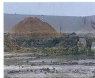
說明：現場堆置之逸散性粒狀污染物
