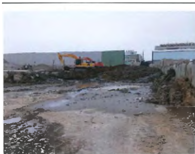
說明：現場堆置之逸散性粒狀污染物
