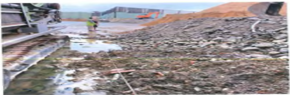
說明：量測土方堆置體積
