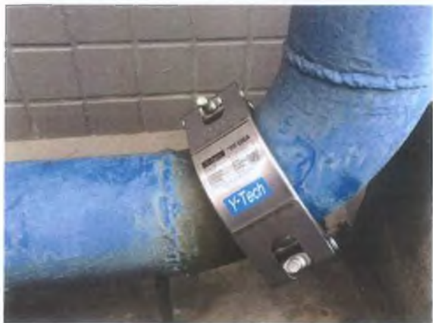
下圖：彎管用止漏管夾，設施送水管彎管處修補 4" (點擊可放大)
