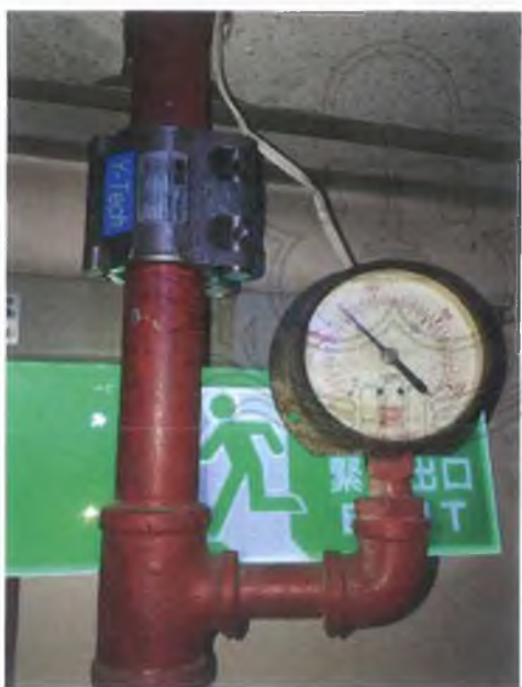
下圖：彎管用止漏管夾，設施送水管彎管處修補 4" (點擊可放大)
