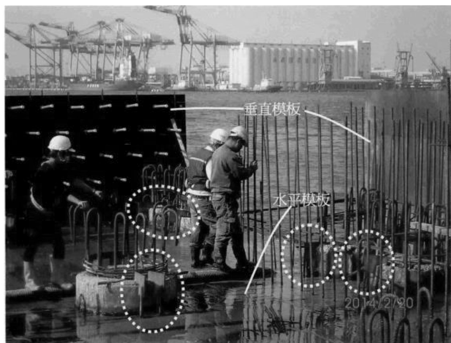
圖 O、證據 20 之碼頭施工照片
