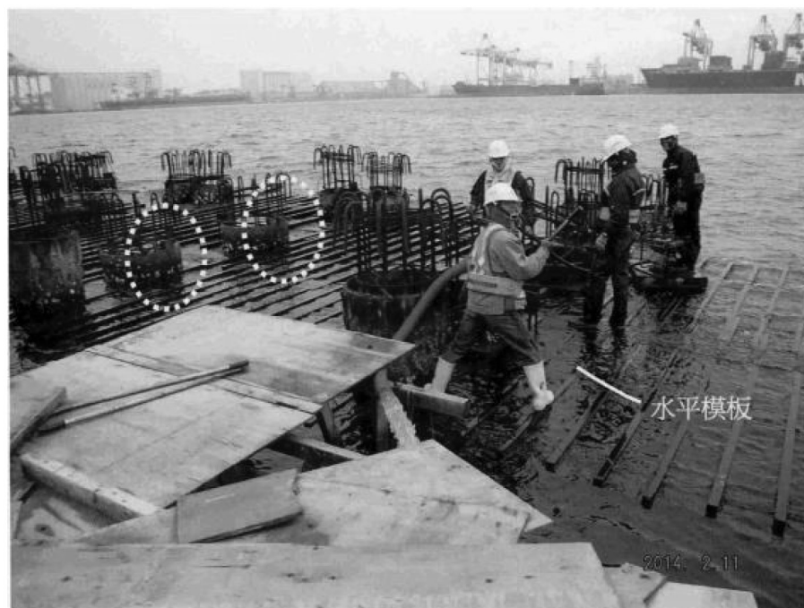
圖 N、證據 19 之碼頭施工照片
